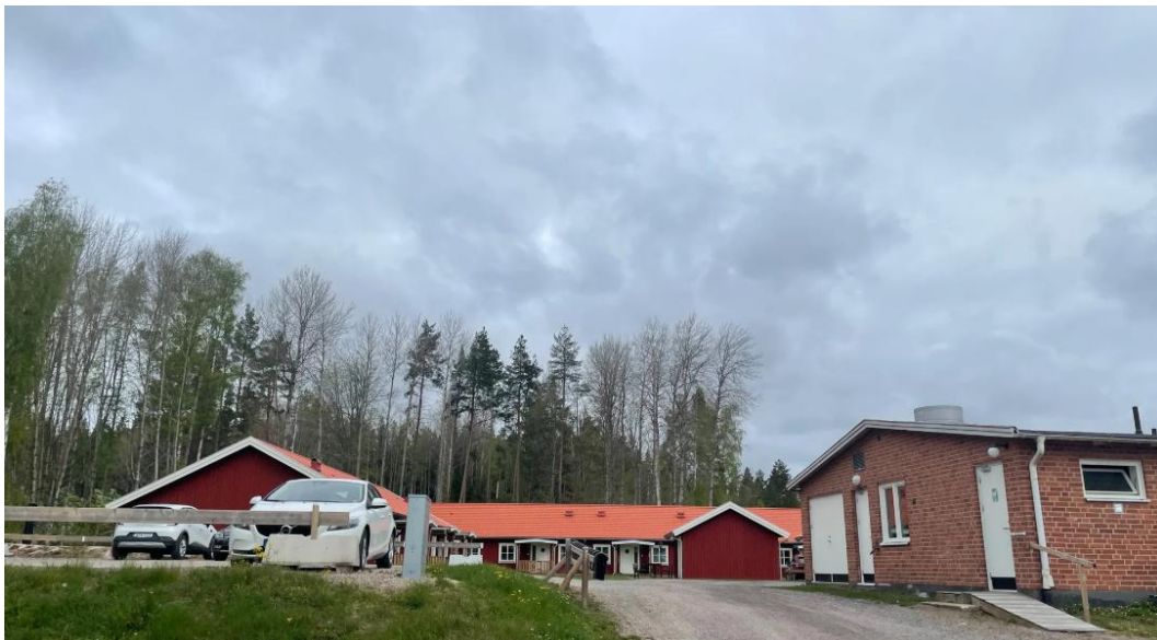
Figur 3. Fastigheten Stavsjo 2:4 utgörs av befintlig bebyggelse i form av radhus. Till höger syns en del av gymnastikbyggnaden som är belägen inom den norra delen av planområdet.
