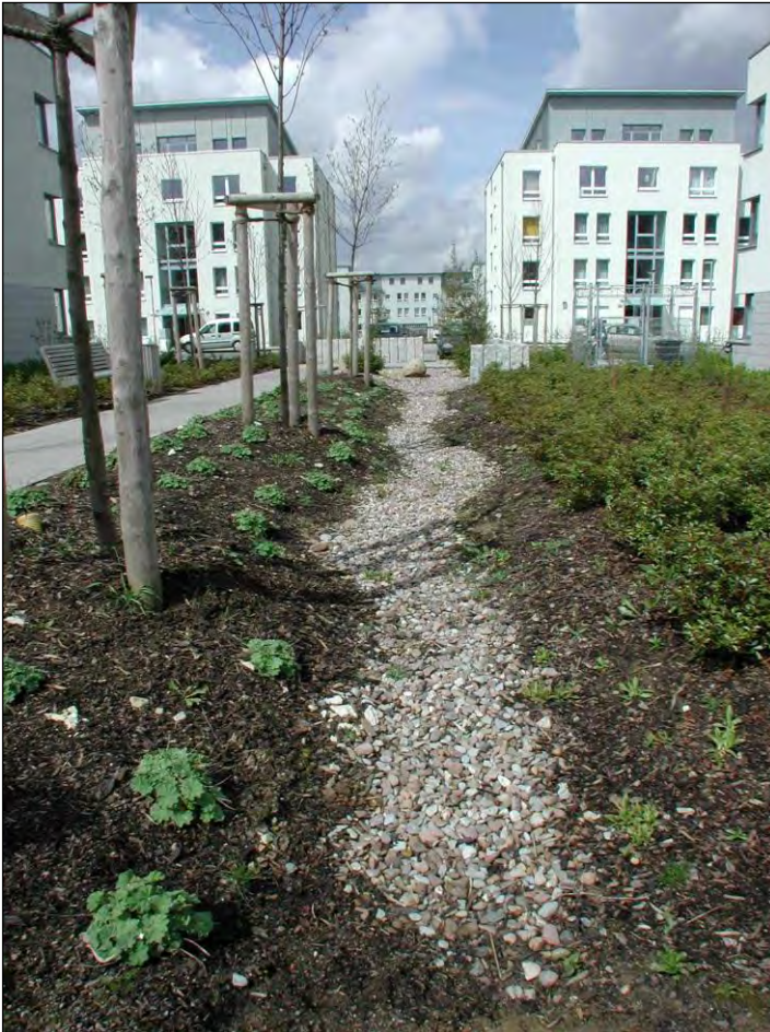
Figur 13. Exempel på utformning av ett makadamdike (Foto: Norconsult)
