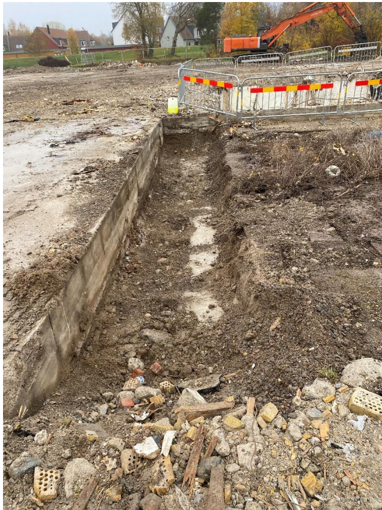
Figur 4. Schaktgrav 21R10 ca 1,2-1,5 bred och ca 0,5 m djup
