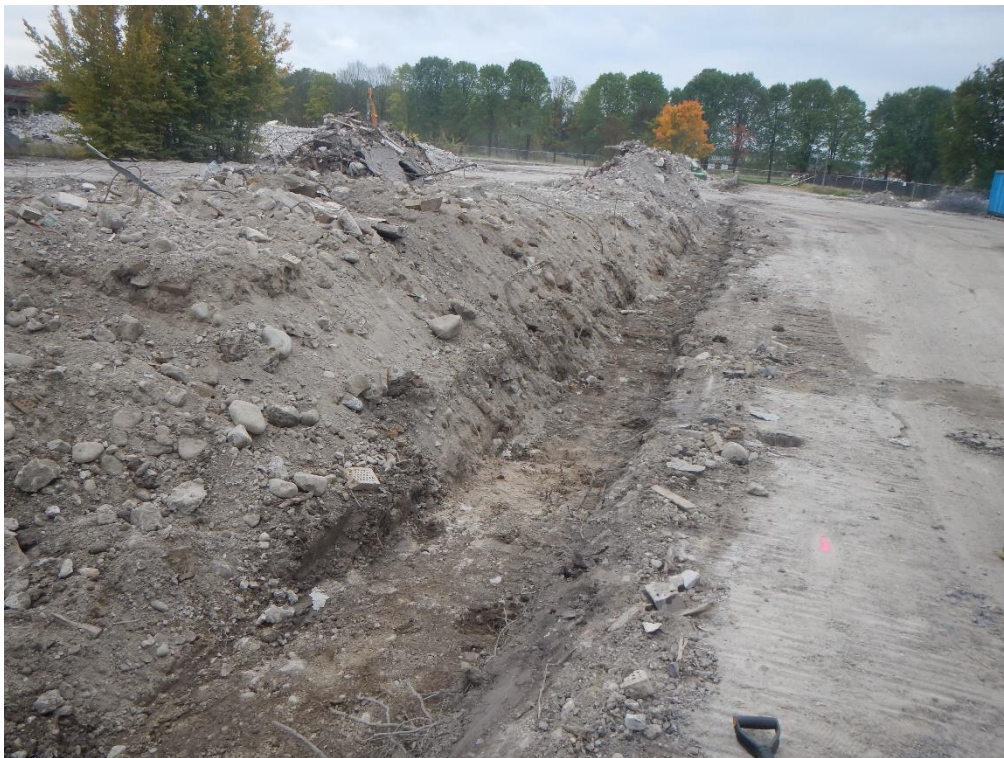
Figur 3 Schaktgrav 21R06 ca 1,2-1,5 bred och ca 0,5 m djup
