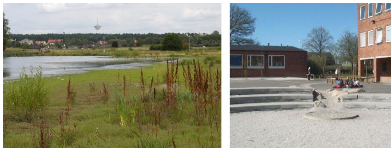
Figur 37 Exempel på överdämningsyta på grönyta (t.v.) samt i skolgårdsmiljö (t.h.). Källa: Stockholm Vatten och Avfall, Anläggningsbeskrivningar (2025-09-01)
