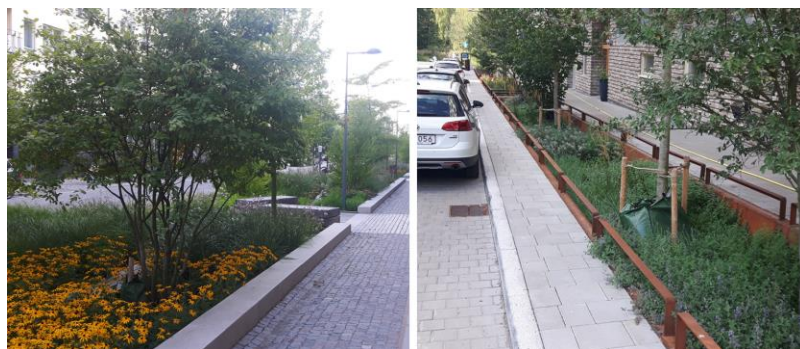
Figur 41 Exempel på nedsänkt växtbädd i gatumiljö med inlopp via kantsten (Norra Djurgårdsstaden). Källa: VA-Verktyget
