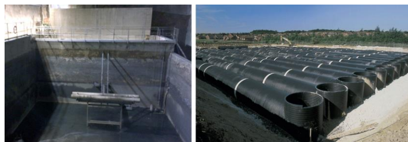
Figur 35 Exempel på platsgjutet avsättningsmagasin (t.v.) samt rörmagasin i plast (t.h.) Källa: Stockholm Vatten och Avfall, Anläggningsbeskrivningar (2025-09-01)
