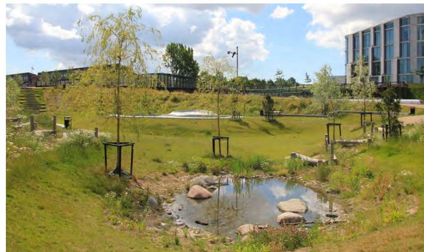
Tydlig lågpunkt i dagvattenanläggningen för ökad förståelse för platsens funktion.
