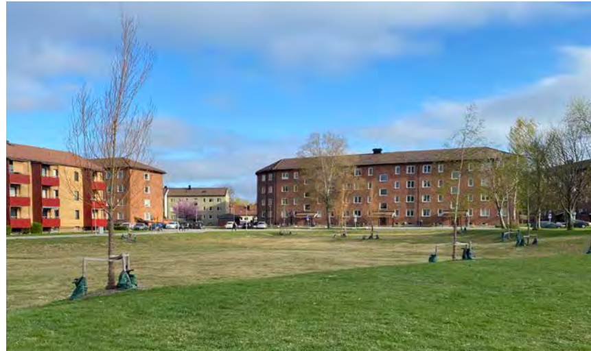
Nedsänkt grönyta fungerar som torrdamm och fördröjningsyta för dagvatten. Referensbild Ljuraparken, Norrköping
