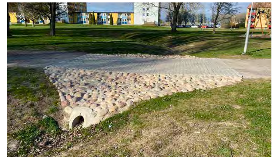
Trumma och överliggande gångväg försedd med natursten över dike. Referensbild Ljuraparken, Norrköping
