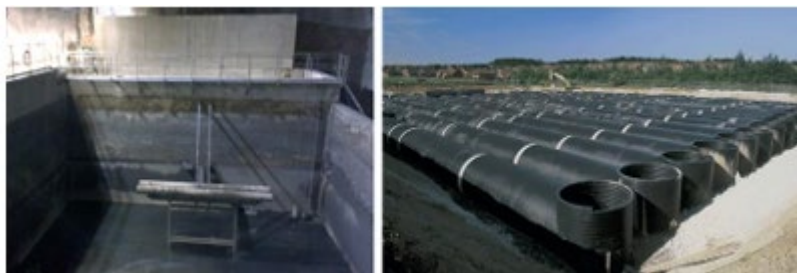
Figur 30. Exempel på platsgjutet avsättningsmagasin (t.v.) samt rörmagasin i plast (t.h.) Källa: Stockholm Vatten och Avfall, Anläggningsbeskrivningar (2025-09-01).
