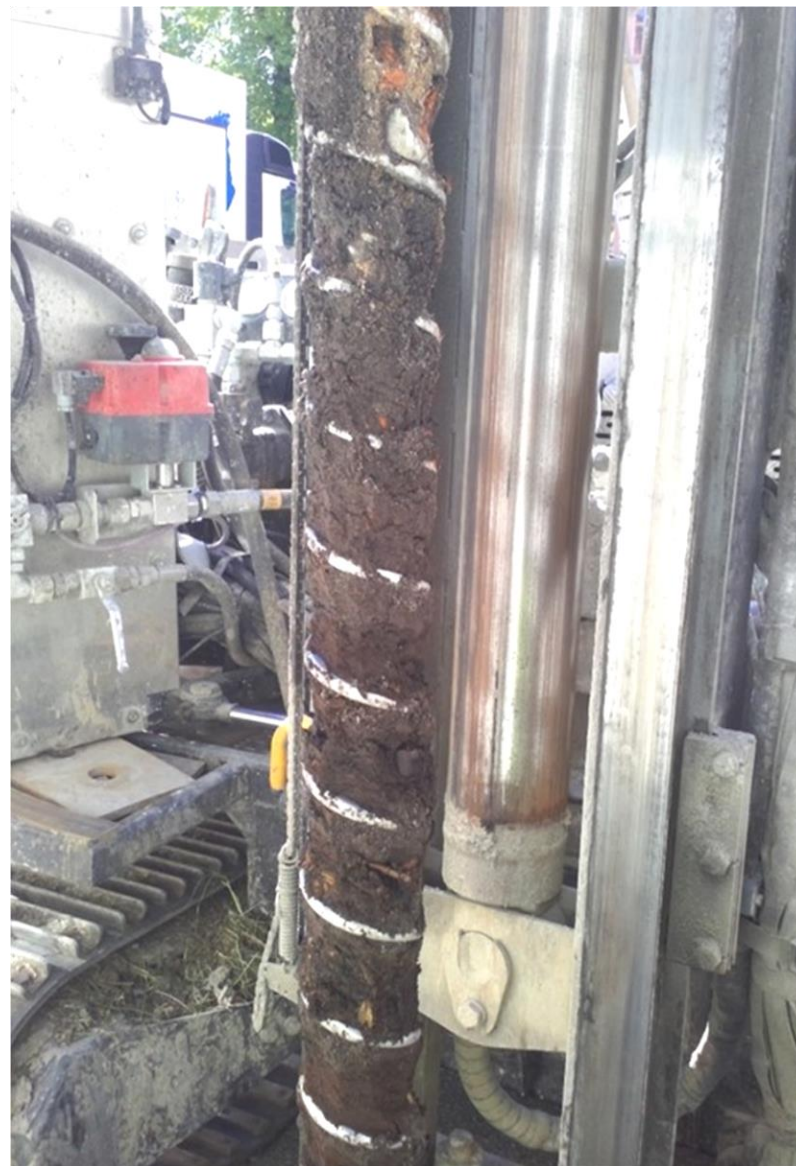
Bild 2: Bild från provpunkt 24INT03 1-2 m. Jordlagret består av mullhaltig jord med tydliga inslag av fyllnads-/byggnadsmaterial i form av träbitar och tegel.
