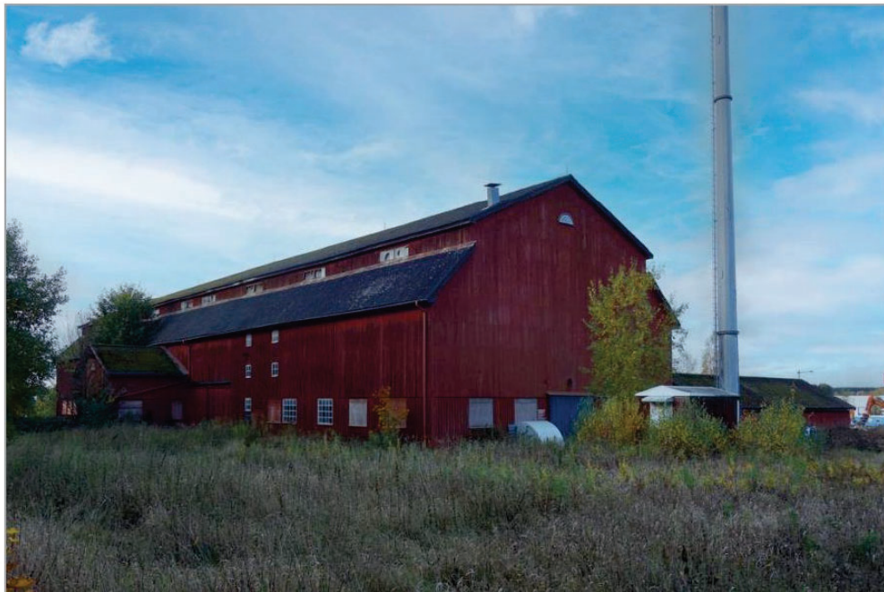
Figur 6. Den stora röda ladugårdsbyggnaden vilket det södra verksamhetsområdet angränsar till i väster. (Foto: Hille Hus o Historia ab, 2022).
