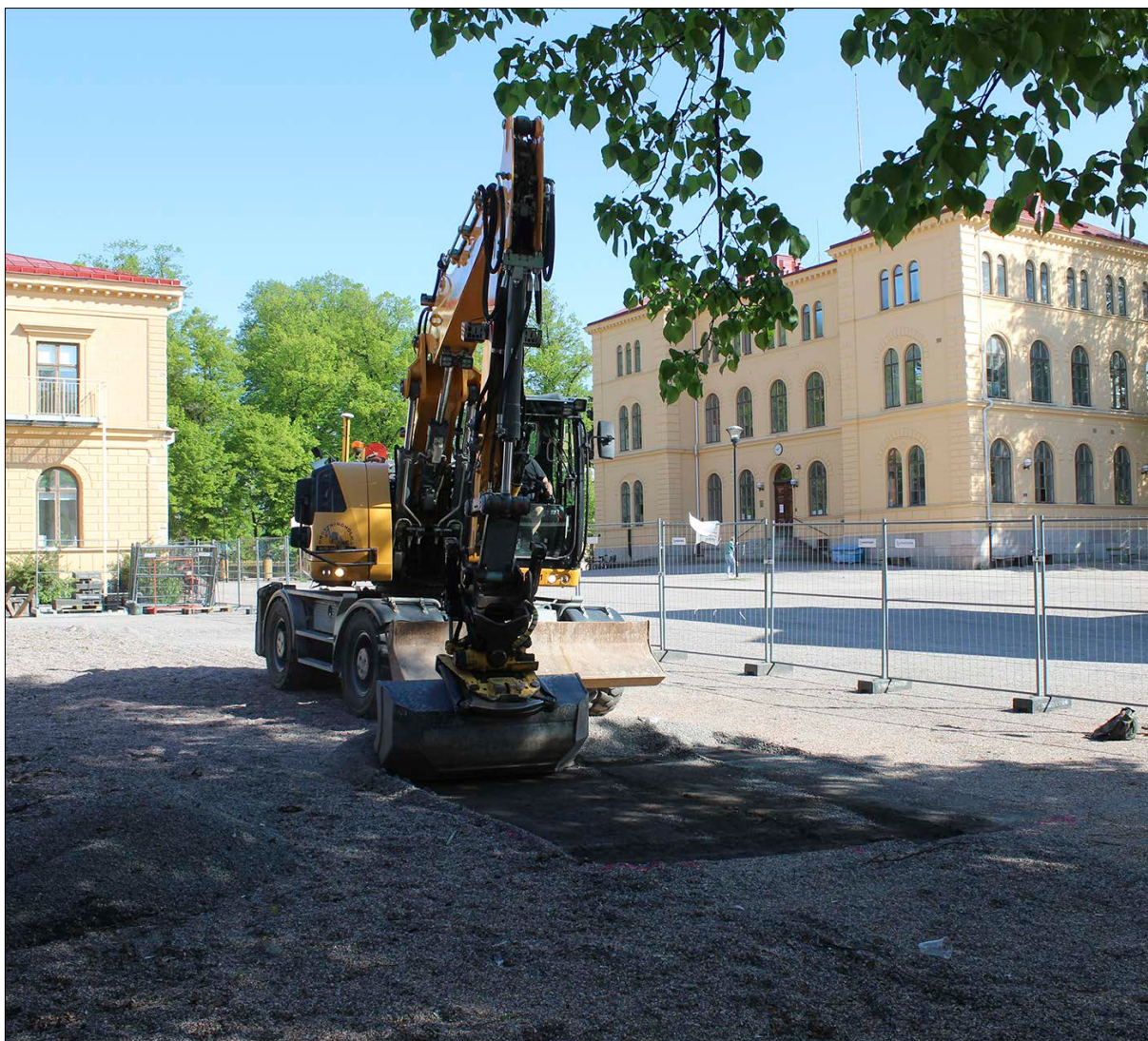
Figur 5. Schaktningen har påbörjats för schakt 1. I bakgrunden syns Nicolaiskolan. Foto från sydväst.
