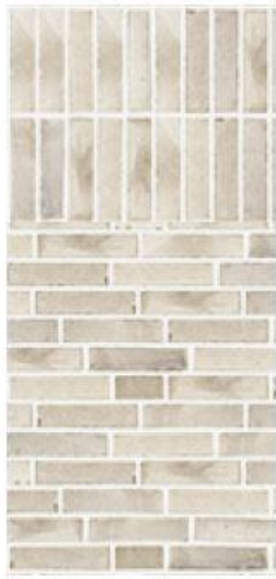
Ljusbeige/sandfärgad/gråbrun tegelfasad med ljus fog, vilt förband och horisontella markeringar av stående stapelförband.
