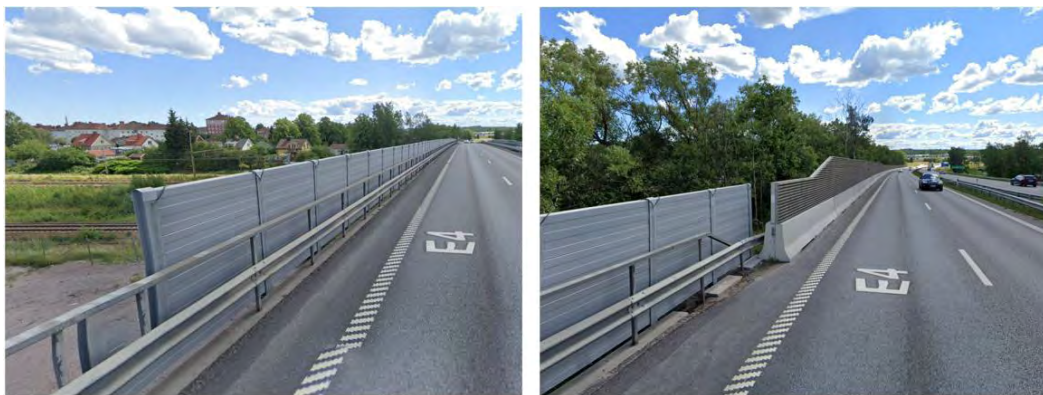
Figur 5. Befintlig skärm cirka 1,5 meter hög till vänster, och cirka 2 meter hög till höger.
