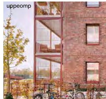
Loftgång mot innergård.
