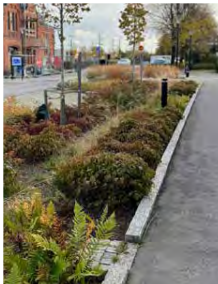
Planteringsytor med regnbäddsfunktion dit vattnet från både stuprör och gata leds för rening och bevattning.
