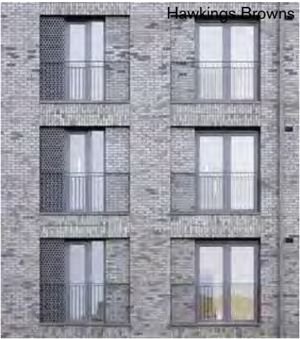
Indraget fasadliv. Fönsterpartier ner till golv.
