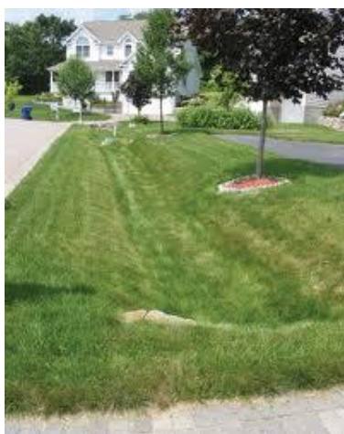
Figur 20: Utvidgat dagvattenstråk samt dagvattenkassetter (Wavin, 2014).
