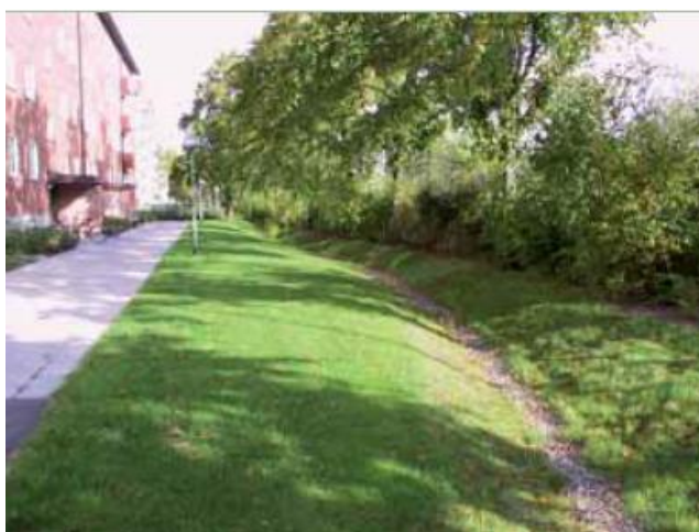
Figur 18: Bild på hur ett svackdike kan utformas (övre bild tagen av WSP och undre är från SLU i Alnarp).
