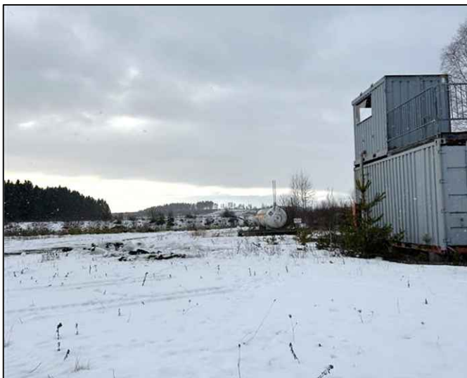
Figur 10. Bilden visar den stora gasoltuben på den norra delen av brandövningsplatsen.
