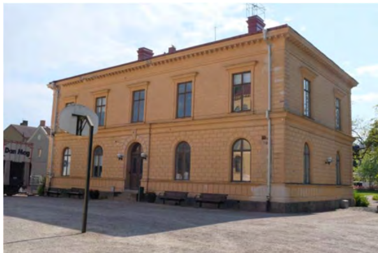
Figur 9: Rektorsbostaden sedd från den angränsande skolgården
