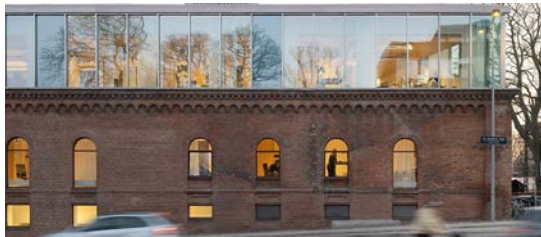
Påbyggnad med olika fasadmotiv Transformation af Rød Lagerbygning i Carlsbergbyen Arkitekt, Sweco
