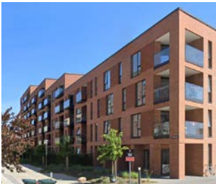
Nedtrappning Pakhuskajen, Odense Arkitekt, C.F. Møller Architects
