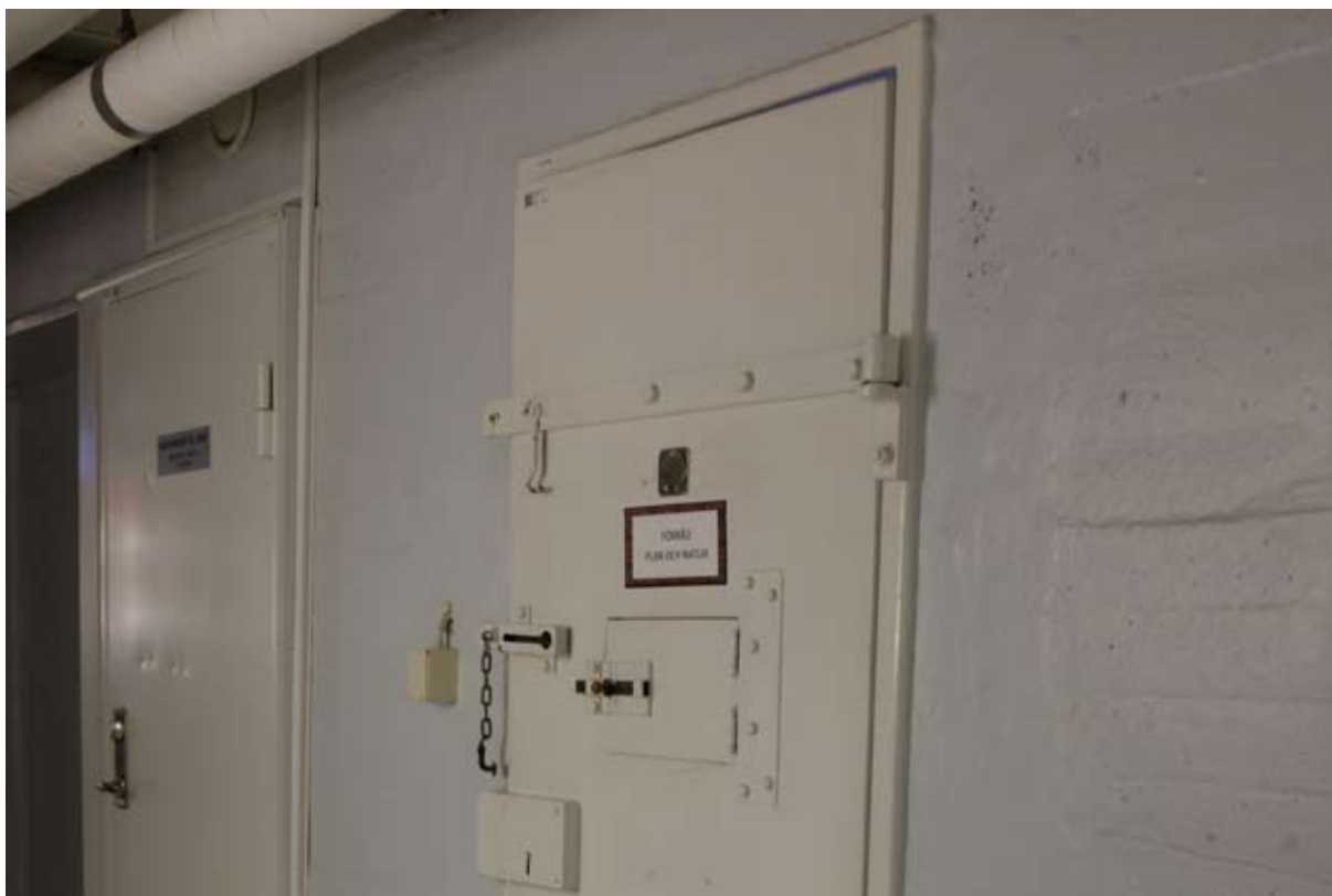
Detalj av bevarad arrestdörr i Stillehusets källare, med lås och lucka.
