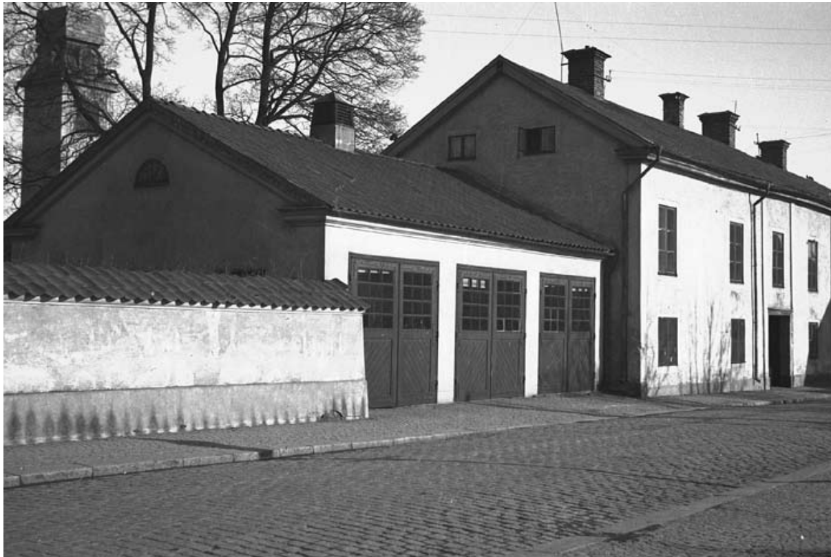
Behmbrogatan från nordväst. Till vänster muren mot det som idag är Johan Skyttes park. Jfr omslagsbilden.
