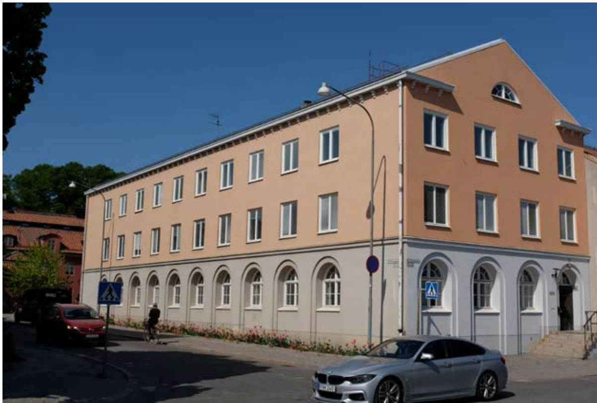
Polishuset, det så kallade Stillehuset från 1950-talet från korsningen Behmbrogatan-Västra Kvarngatan. Jfr bilden på s. 14.
