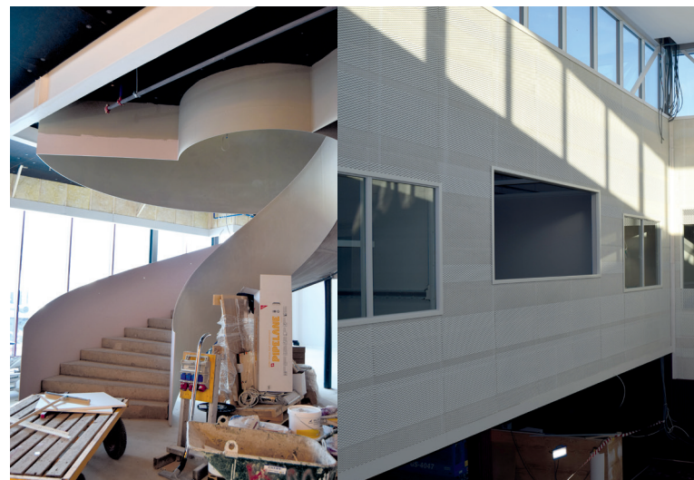
En trappa gjord i fartygsstål är bara en av de hållbara detaljerna i nya gymnasiet.
