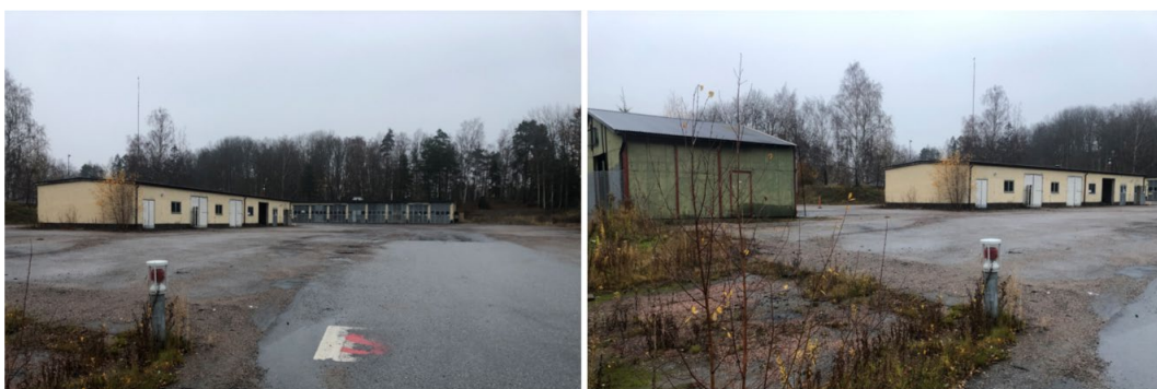
Bilder som föreställer tre av byggnaderna på fastigheten.
