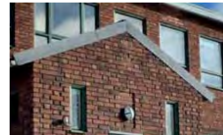
Wedholms kontorsbyggnads fönster och indragna fogar beaktas.
