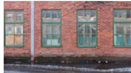
Maskinhallens spröjsade fönster bevaras.
