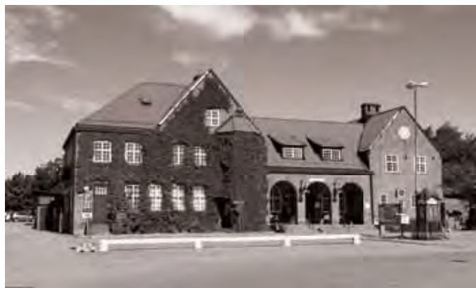
Befintlig stationsbyggnad söder om järnvägen
