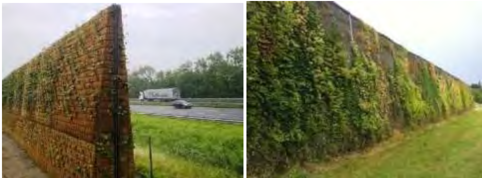
Referensbilder på bullerskärm uppförd som grön vegetationsvägg
