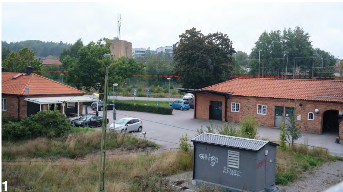
Figur 8-8: Vy från gångbron sydväst om stationen. Höjden på bullerskärmen är uppskattad i bilden och markerad med en sträckad linje. Sett till omfattningen av den planerade bebyggelsen innebär skärmarna en begränsad påverkan i sammanhanget.
