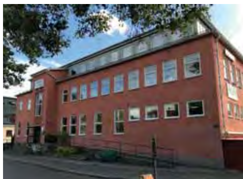
Omvandling verksamhetsbebyggelse. Nyköping
