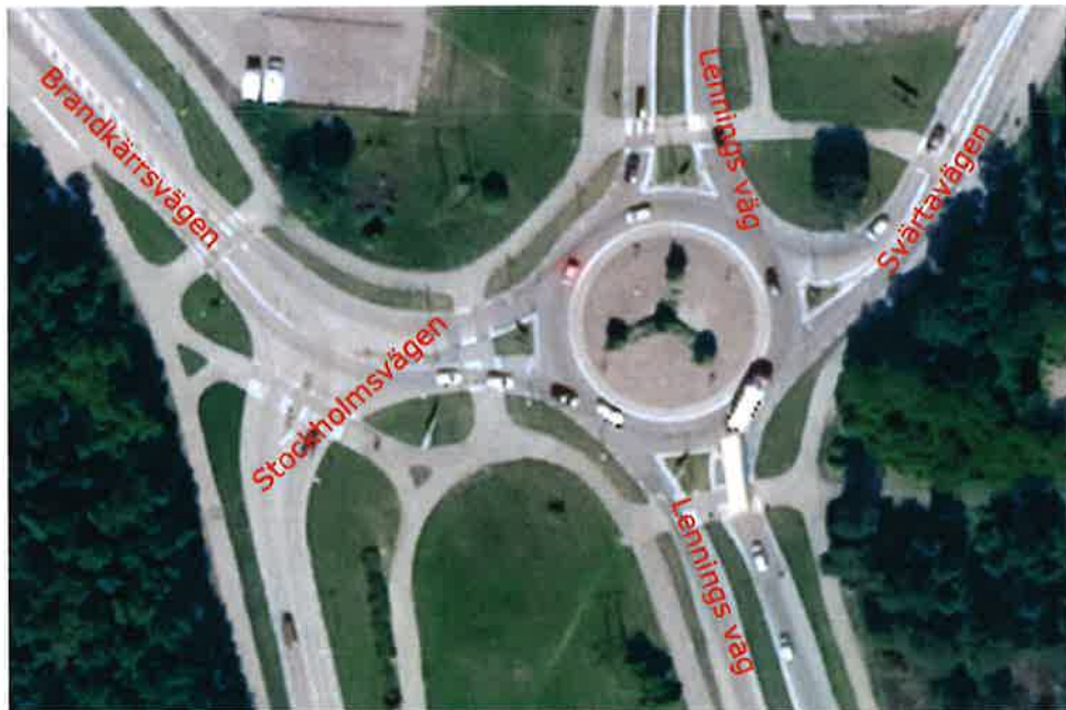
Figur 10 - Ekensbergsrondellen samt korsningen Stockholmsvägen / Brandkärrsvägen
