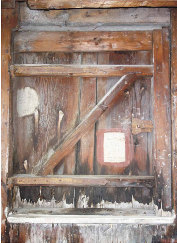
Äldre lucka i torn ska bevaras och renoveras.
