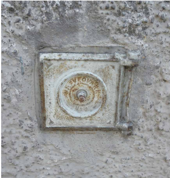
Äldre gjutjärnsventil från Näfverqvarn ska bibehållas och renoveras.
