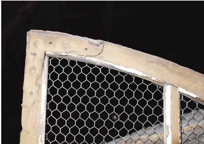
Äldre båge med ett brunt färgskikt och vad som kan vara ett ursprungligt hörnjärn ska undersökas i syfte att ta fram en snickerikulör som bättre överensstämmer med rådbusets 1700-talsutseende. När färgen blöts upp är den betydligt mörkare än utseendet på fotot.
