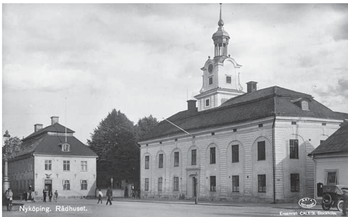
Fotografi från ca 1912-1930. Notera den mörkare fönsterkulören. Bakom rådhuset skymtar den tidigare flygeln som revs under 1900-talets andra hälft. På tornet kan en stående panel anas (Nyköpings kommuns bildarkiv, bildnr. NKBEA_VYGE238).
