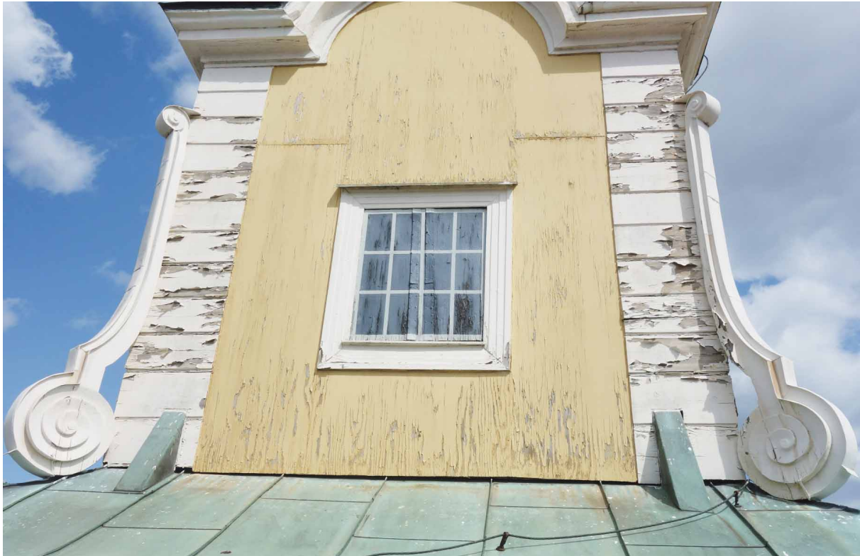
Sentida skivmaterial på klocktornets fasad. Färgskiktet flagar kraftigt på trädetaljerna.
