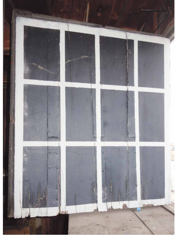
Samma lucka från utsidan, målad för att imitera ett fönster. Notera järnbanden som har spikats ovan panelbrädornas skarvar.
