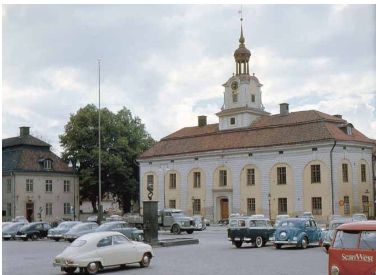
Fotografi från 1960-talet innan den utvändiga renovering som genomfördes i slutet av årtiondet. Tornhuven är ännu täckt av galvad plåt. (Nyköpings kommuns bildarkiv, bildnr. NKBEA_UIW193).
