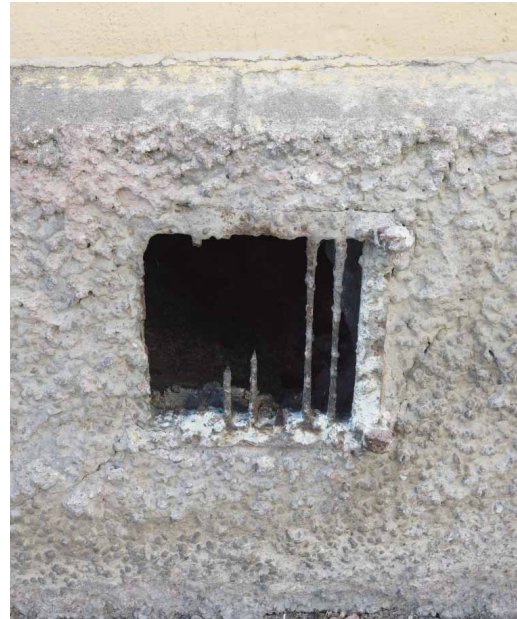
Skadade galler i sockel ska ersättas av nya så lika befintliga som möjligt.
