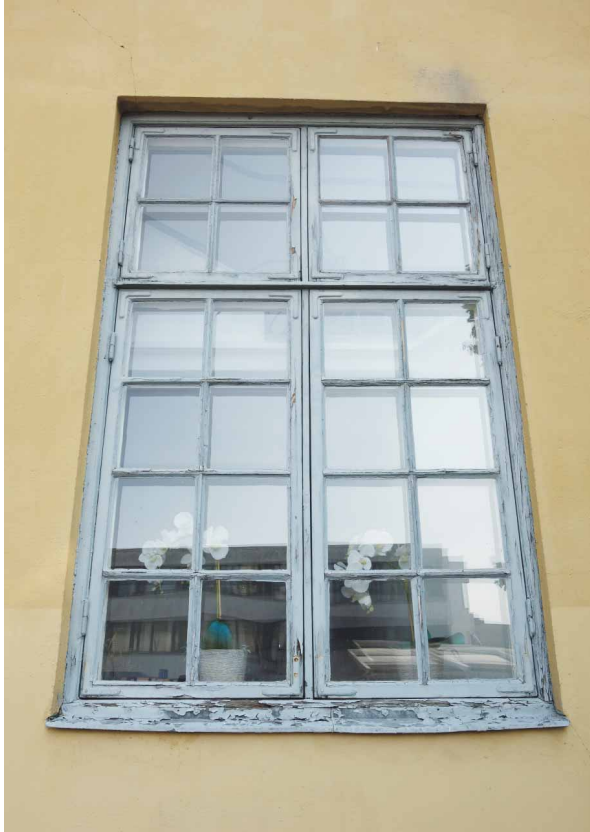
Korspostfönster med kopplade utåtgående fönster dominerar.
