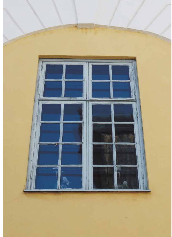
Ett fåtal äldre korspostfönster med separata inner- och ytterbågar förekommer, här i övre våningen i västra fasaden.
