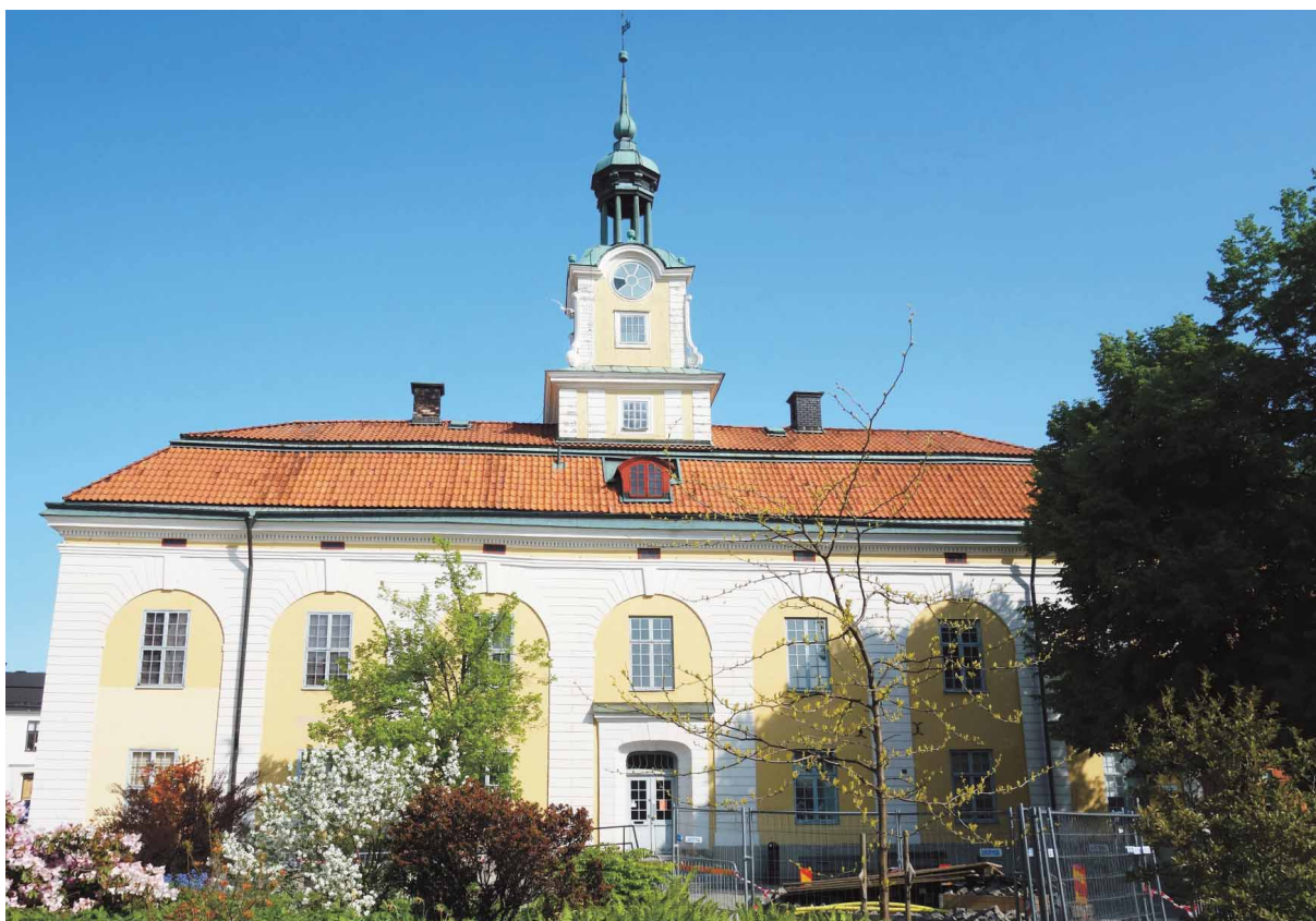
Nyköpings rådhus, fasad mot söder.
