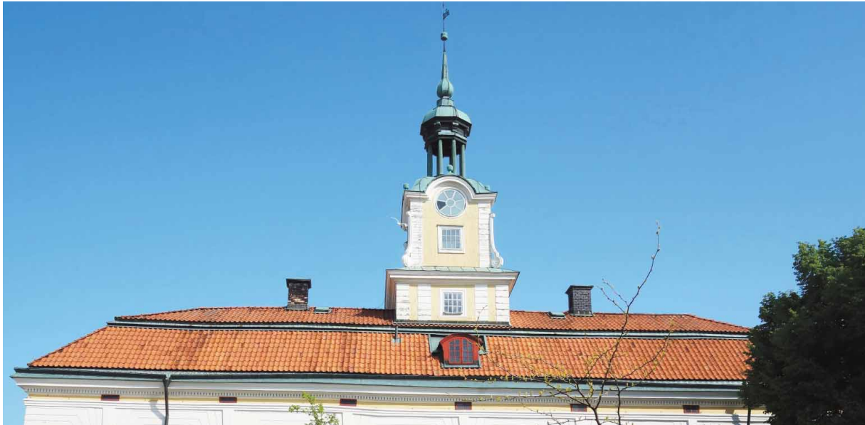
Takfall mot söder med nockeräcken och två takluckor mellan skorstenar och torn.
