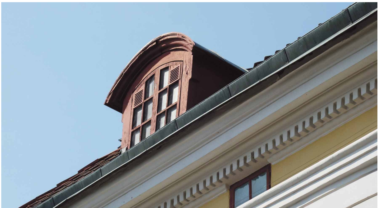
Takkupa mot öster med front och fönster i plywood.
