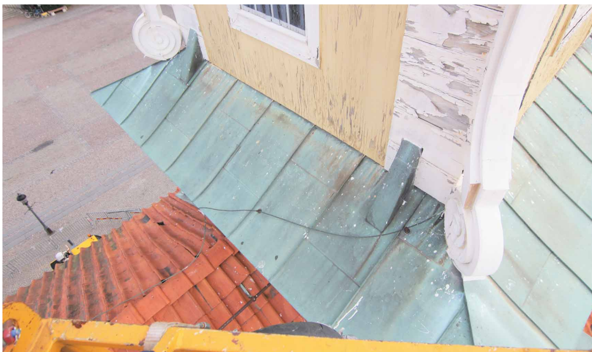
Befintlig takplåt på tornets nedre takfall.
