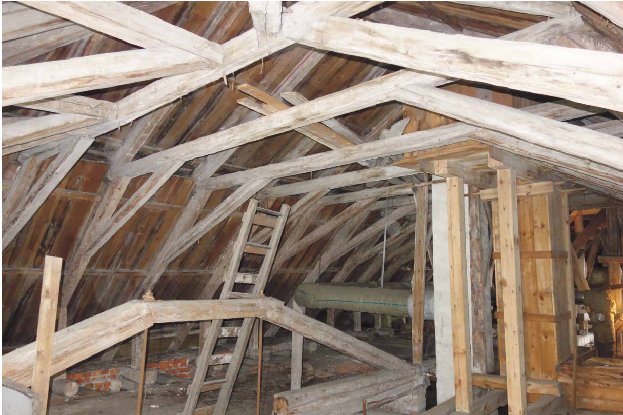
Rådhusvinden med takstolskonstruktion och underlagstak som måste bevaras.
