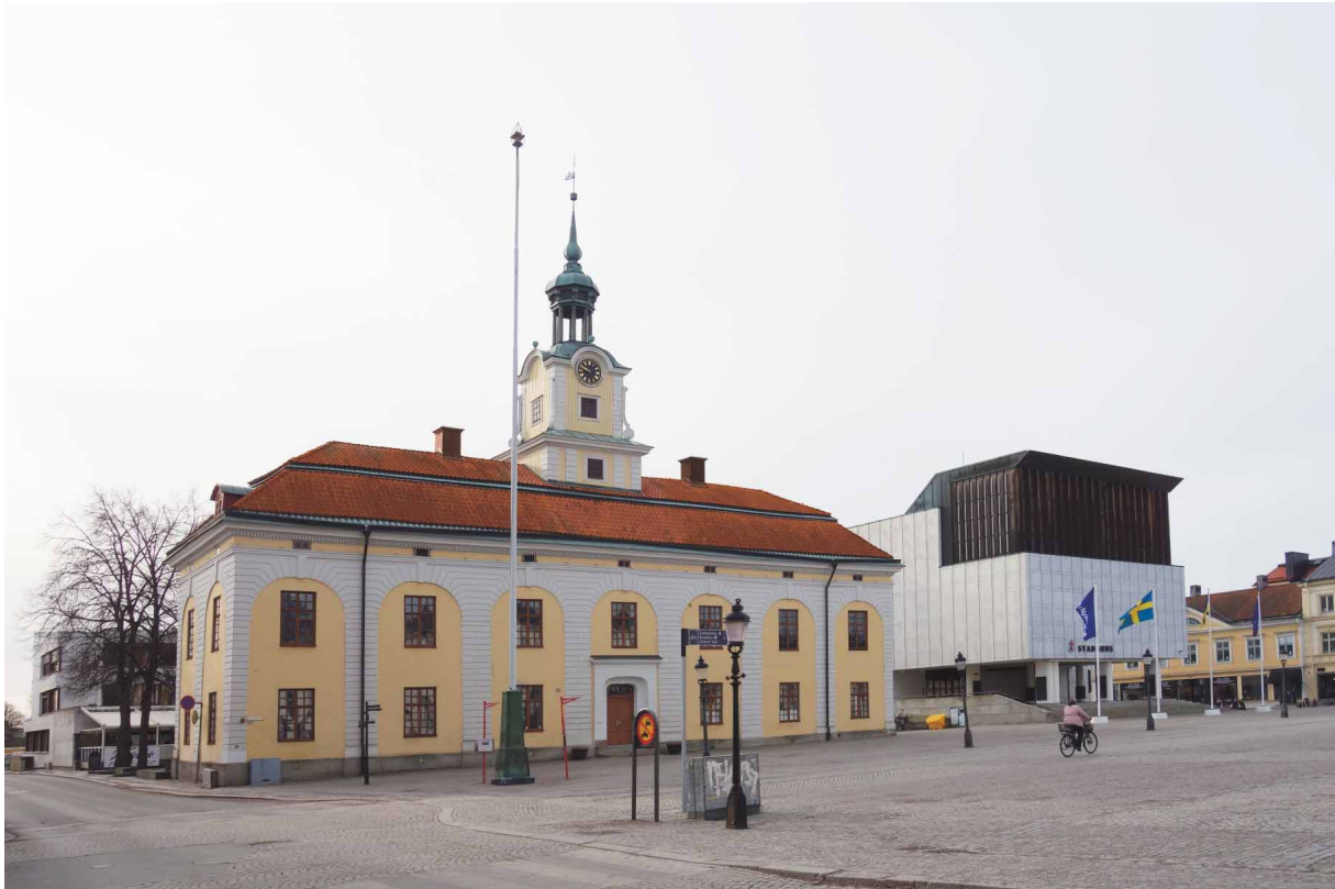
Möjlig ny färgsättning med en någon mildare gul fasadkulör, en lite mindre skarpt vit kulör på listverk samt mörkt rödbruna fönster och dörrar likt kulör som finns under ljusgrått färgskikt på befintliga fönster.
