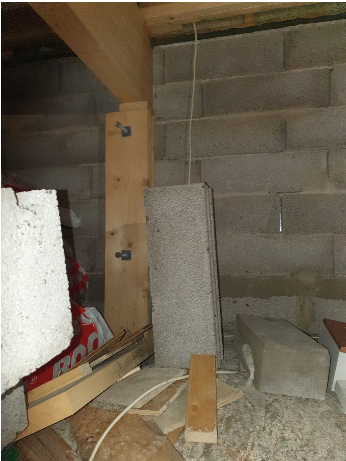
Bllaga 13 / Grunden, här ser vi hur låg grunden är inuti källaren
