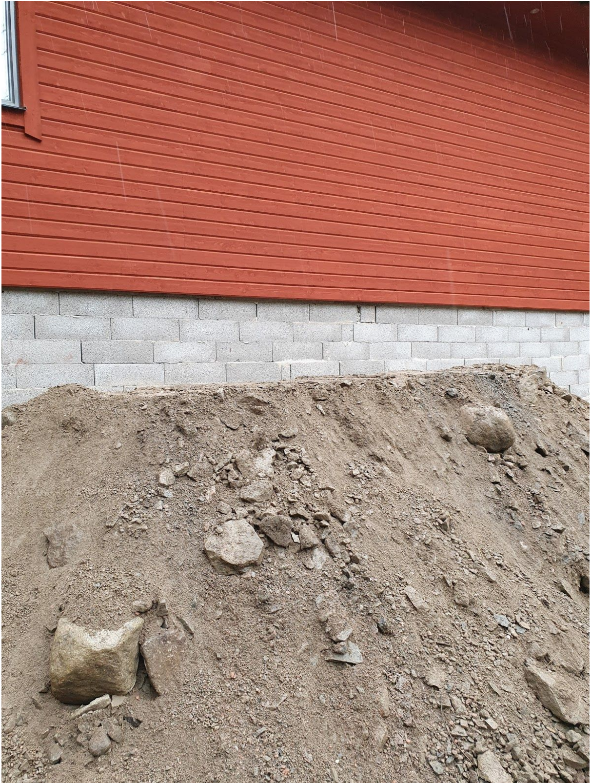
Bilaga 10 / Uppfyllnad mot vägen
