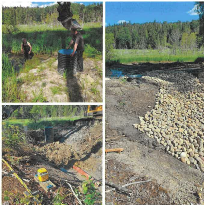
Bild. Våtmarksrestaurering med munk och stensatt omlöp för en stabil och funktionell våtmark gynnar både biologisk mångfald och vattenkvalitet.
