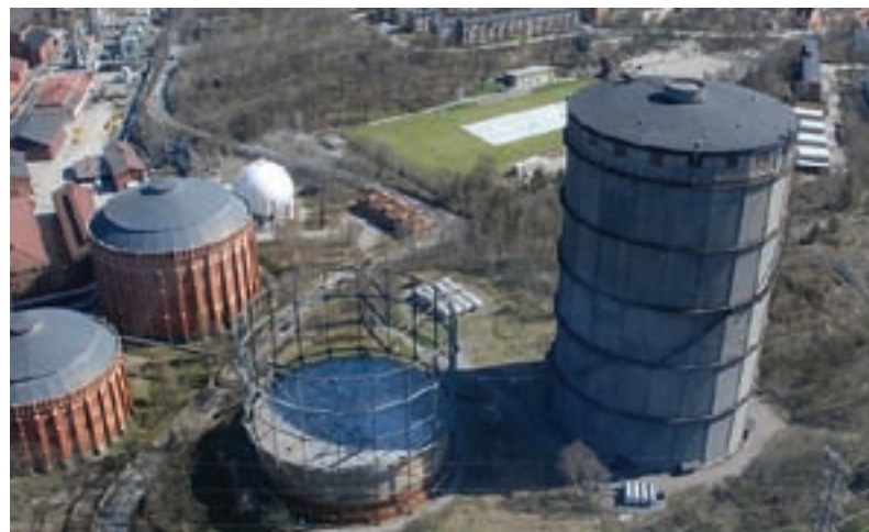
Gasklockorna i plåt, gasklocka 3 och 4, (till höger om Bobergs gasklockor i tegel) ska enligt planer omvandlas till bostäder. (Foto: Oscar Properties)
