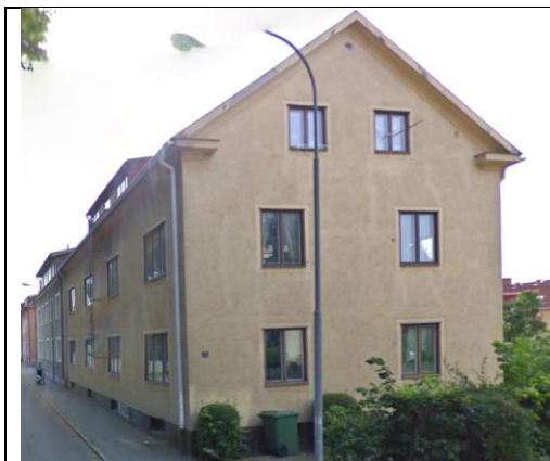
Bild 4. Skrivaren 12 - Södra Bangårdsgatan 8 Byggår 1935 Bostadshus med källare troligen träbjälklag Grundläggning på grundsula Mätplats: Sovrum på entréplan
