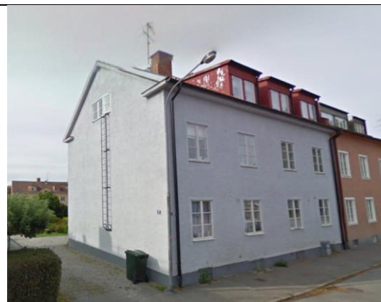
Bild 5. Skrivaren 15 - Södra Bangårdsgatan 14 Byggår 1935 Bostadshus med källare och träbjälklag Grundläggning på grundsula Mätplats: Hall på entréplan
