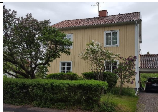
Bild 2. Filen 6 - Norra Bangårdsgatan 13 Hus med torpargrund och träbjälklag Grundläggning på grundsula Mätplats: vardagsrum på entréplan
