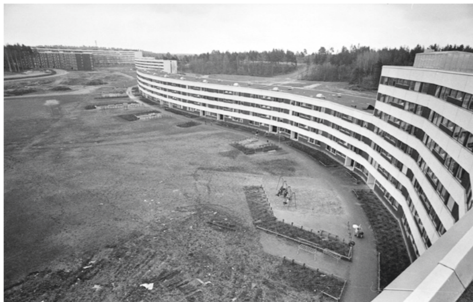
Bild från när Brandkärr byggdes
