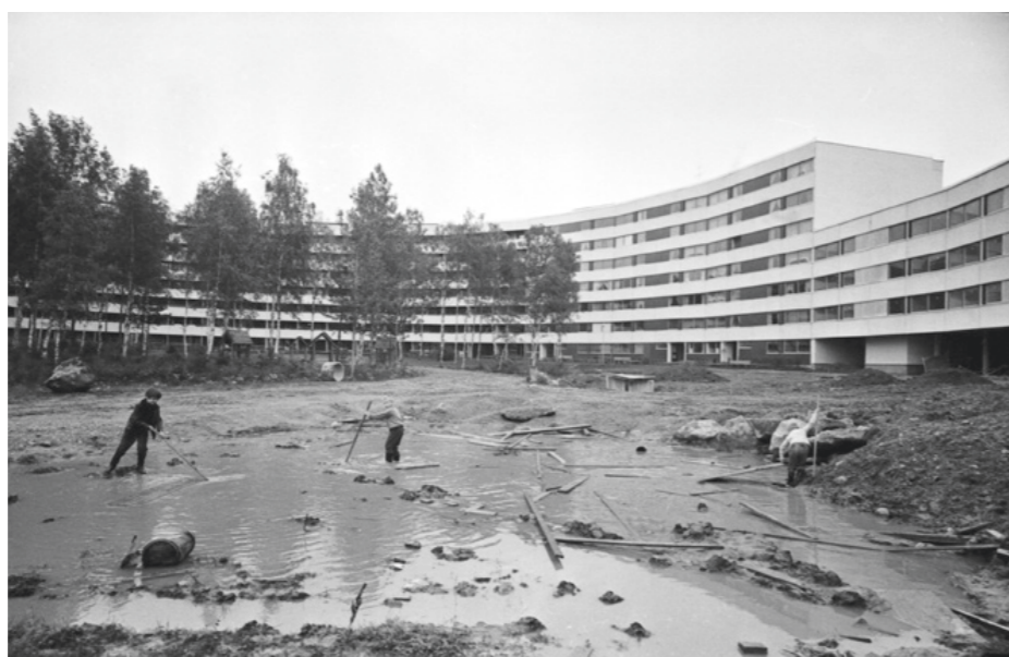
Bild från när Brandkärr byggdes
