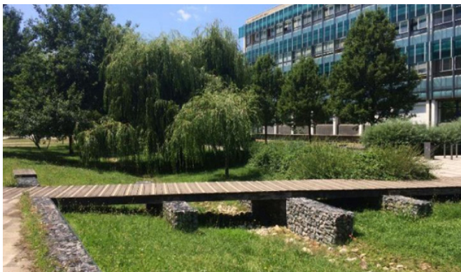
Exempel på nedsänkt vegetationsstråk som kan hantera stora vattenvolymer. (SVU Rapport 2019-20)
